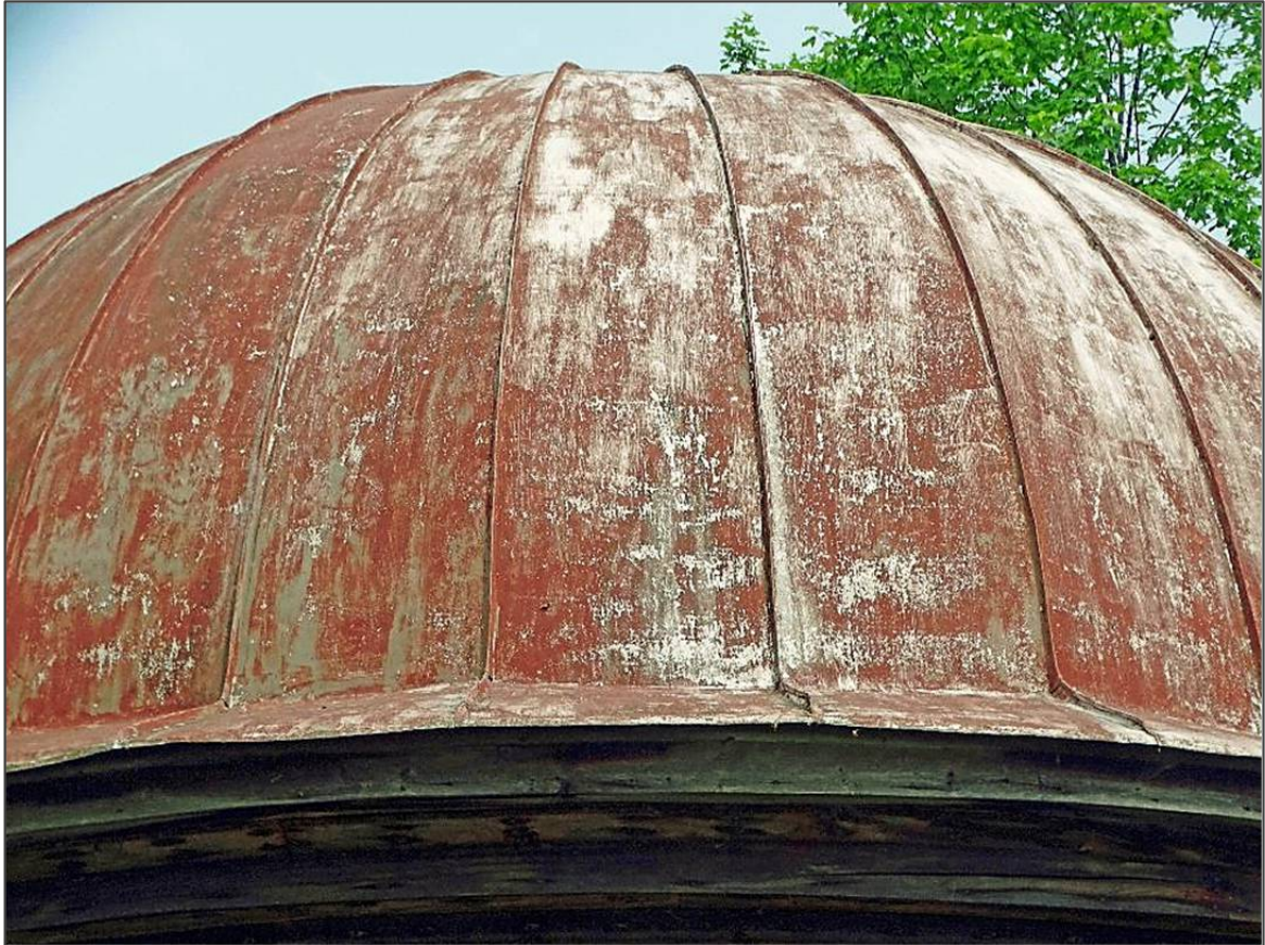
Abb. 47: Halbkugelförmige Kuppel mit per Falz verbundenen Blechsegmenten. Quelle: Foto R.S. Zappe, 2025.
