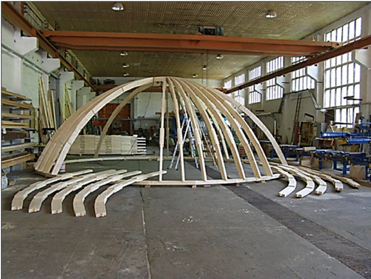
Abb. 51: Halbkugelförmige Holzkuppelkonstruktion mittels Bogenbohlen am Beispiel der Konstruktion des Zimmermeisters Jörg Kunze aus dem sächsischen Amtsberg für die russisch-orthodoxe Kirche St. Elon am Ölberg in Jerusalem. Quelle: www.baunetzwissen.de , Foto Jörg Kunze, Amtsberg, 2008.
