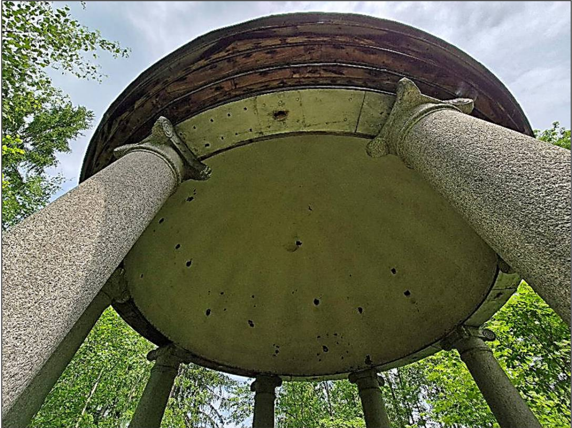
Abb. 42: Rundtempel-Kuppel von unten: Man sieht die Schadstellen im Gebälk (Loch) und an der Kuppel-Unterseite (Löcher und Risse). Quelle: Foto R.S. Zappe, 2025.
