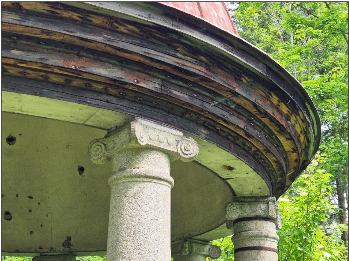
Abb. 41: Rundtempel-Detail mit Säulen-Kapitell, Balken und Kranzgesims. Quelle: Foto R.S. Zappe, 2025.
