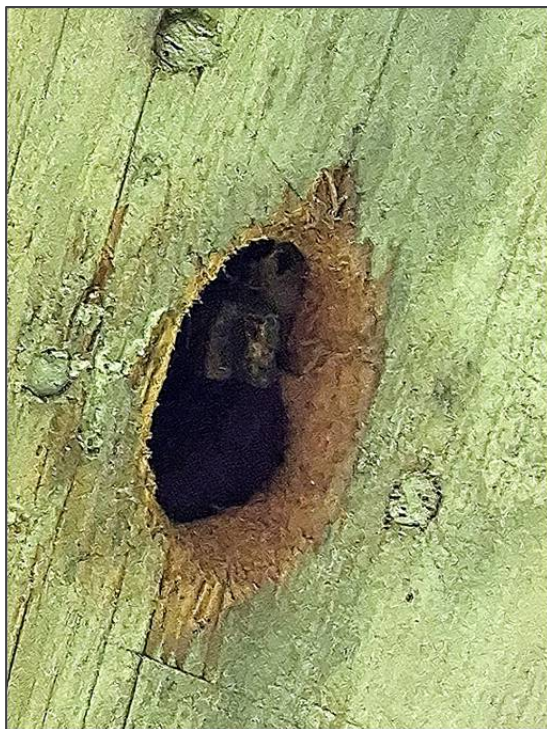
Abb. 43 und 44: Schadstellen im Gebälk (links) und an der Kuppel-Unterseite (rechts). Sichtbar sind auch die alten Holzdübel im Gebälk (links). Quelle: Fotos R.S. Zappe, 2025.
