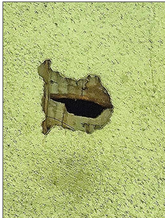
Abb. 43 und 44: Schadstellen im Gebälk (links) und an der Kuppel-Unterseite (rechts). Sichtbar sind auch die alten Holzdübel im Gebälk (links). Quelle: Fotos R.S. Zappe, 2025.
